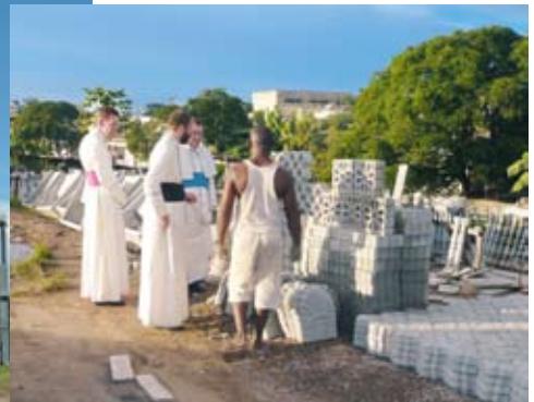
Auf der Suche nach geeigneten Baumaterialien am Straßenrand der Hauptstadt Libreville.
