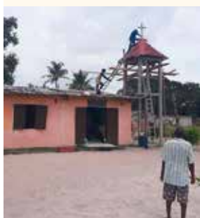
Bau des Glockenturms in Point-Denis.
