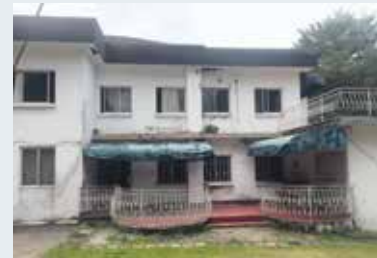
Viele Arbeiten sind noch nötig, bevor dieses Haus den Anbetungsschwester als Konvent dienen kann.
